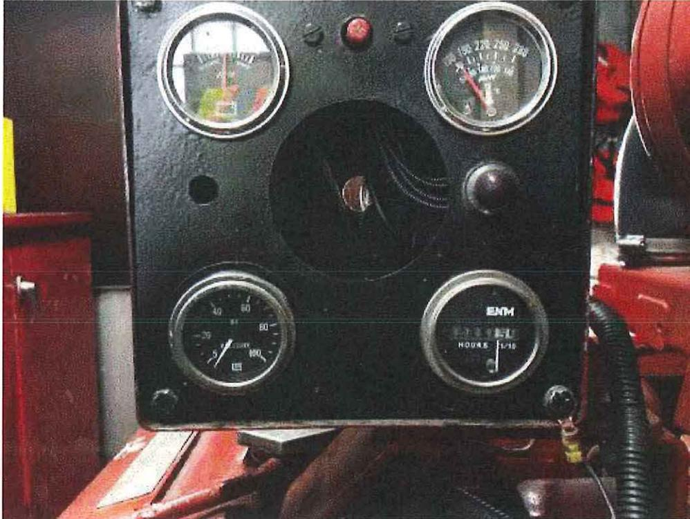
**Image 7(EUFIREPUMP)** : Hour meter on EUFIREPUMP.
