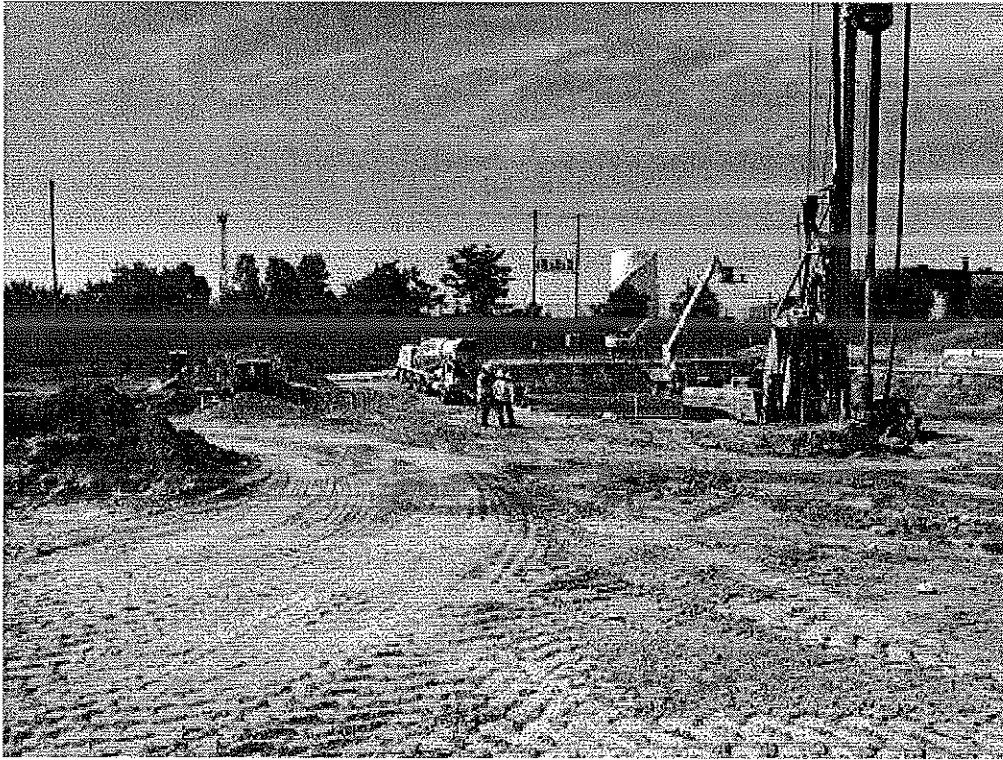
Image 1(GRWWTP) : Digester Site
