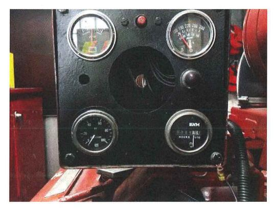
Image 7(EUFIREPUMP): Hour meter on EUFIREPUMP.
